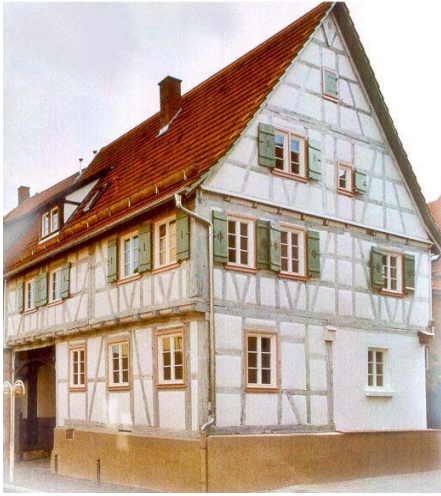
Vorderansicht des Gebäudes
